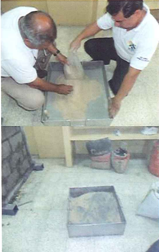
Figura 2. Materiales componentes de la pasta de mortero
