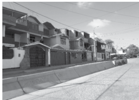
Foto 3 y 4: Viviendas con material constructivo predominante de concreto, ladrillo y techos aligerados, acabado de tarrajeo con cemento pulido y pintado
