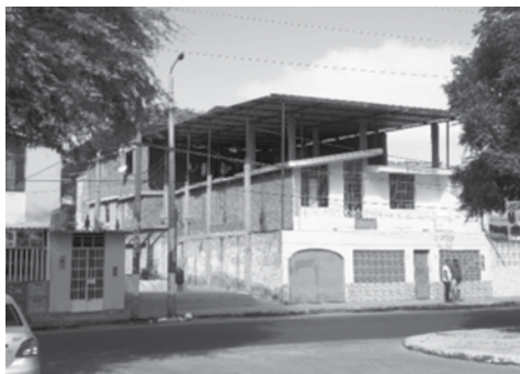
Foto 3 y 4: Viviendas con material constructivo predominante de concreto, ladrillo y techos aligerados, acabado de tarrajeo con cemento pulido y pintado
