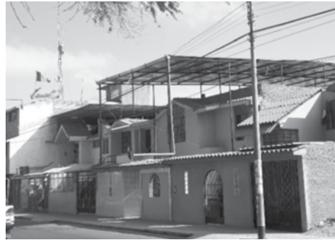
Foto 1 y 2: Viviendas típicas en los Distritos de Piura, 26 Octubre y Castilla, adaptación de techos para protección solar y lluvias
