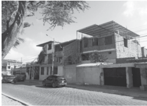
Foto 1 y 2: Viviendas típicas en los Distritos de Piura, 26 Octubre y Castilla, adaptación de techos para protección solar y lluvias
